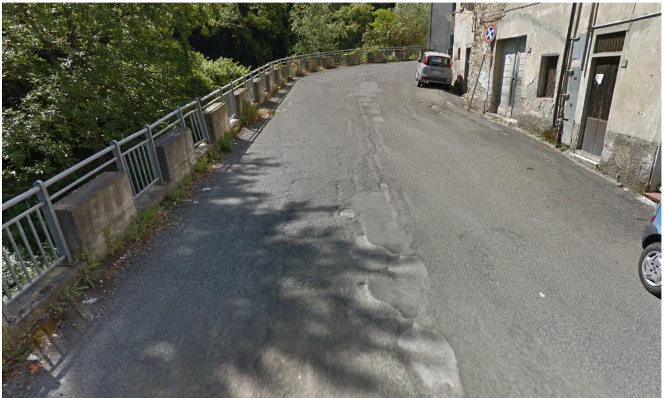
SP 19 intera tratta dal Km. 0+000 al Km. 4+241
