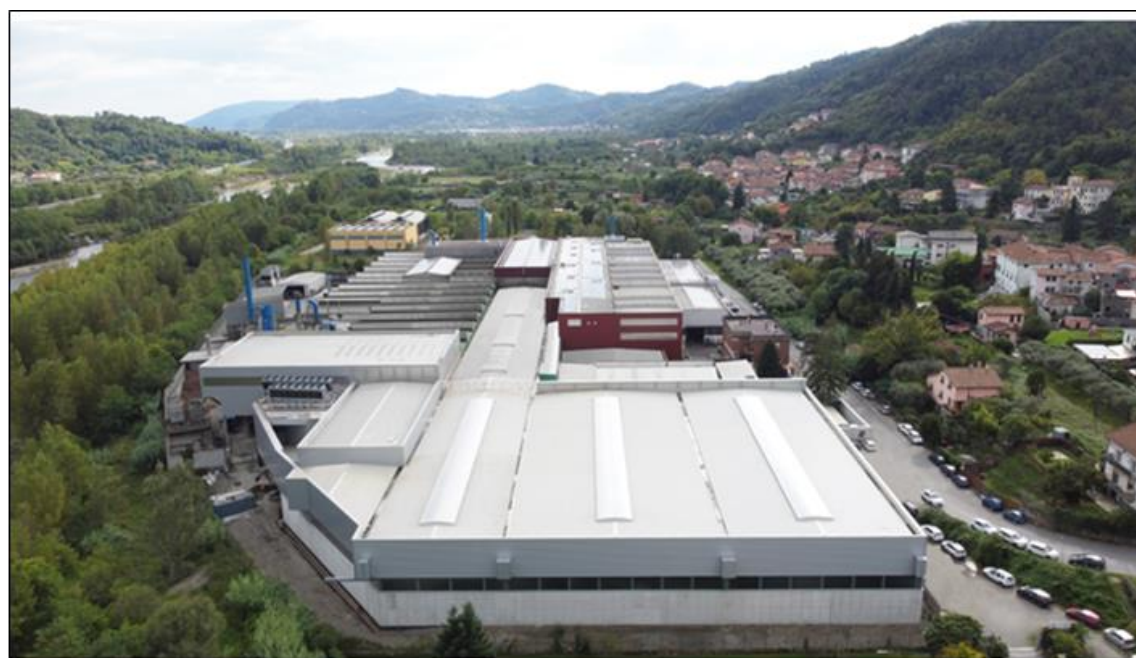
Figura 2 Visione dello stabilimento con zona retrostante
