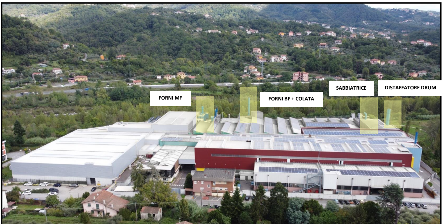
Figura 3 In figura sono evidenziati i camini con portata volumetrica maggiore in stabilimento
