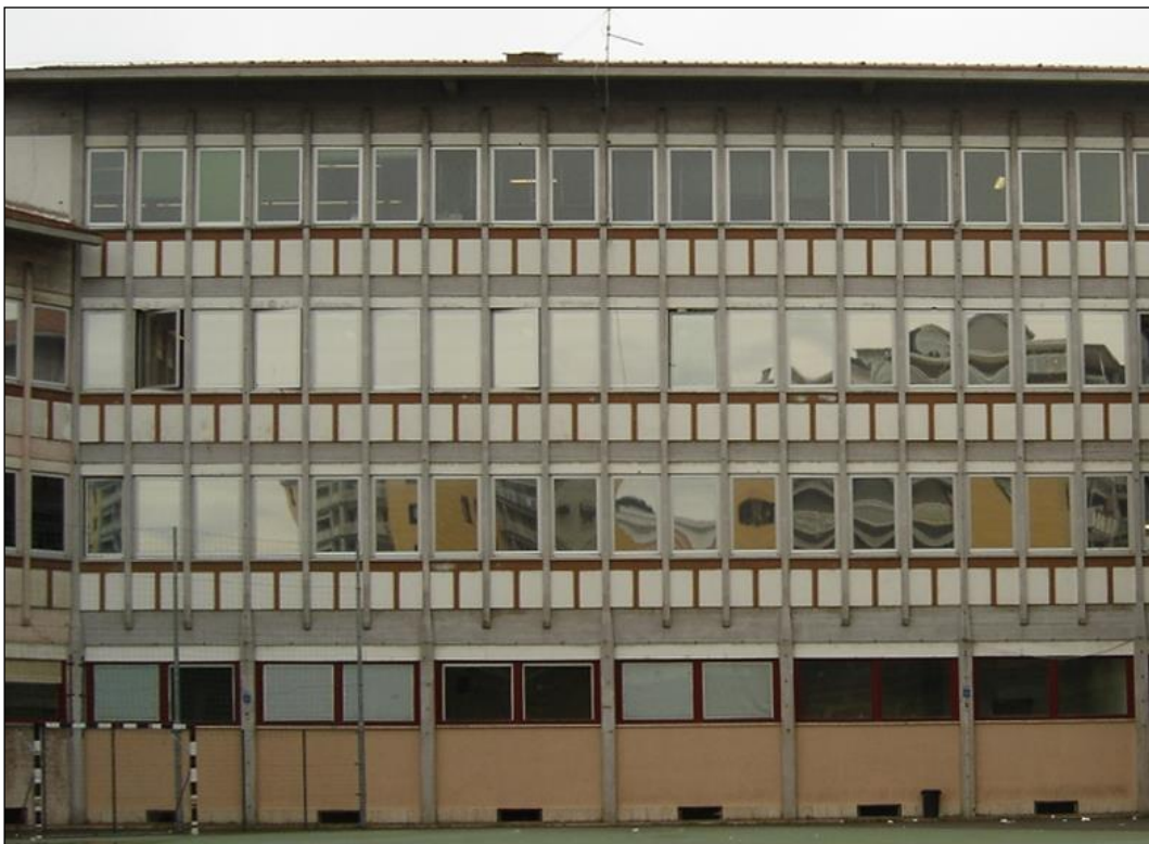
Fig. 1-2 Prospetto interno lato cortile
