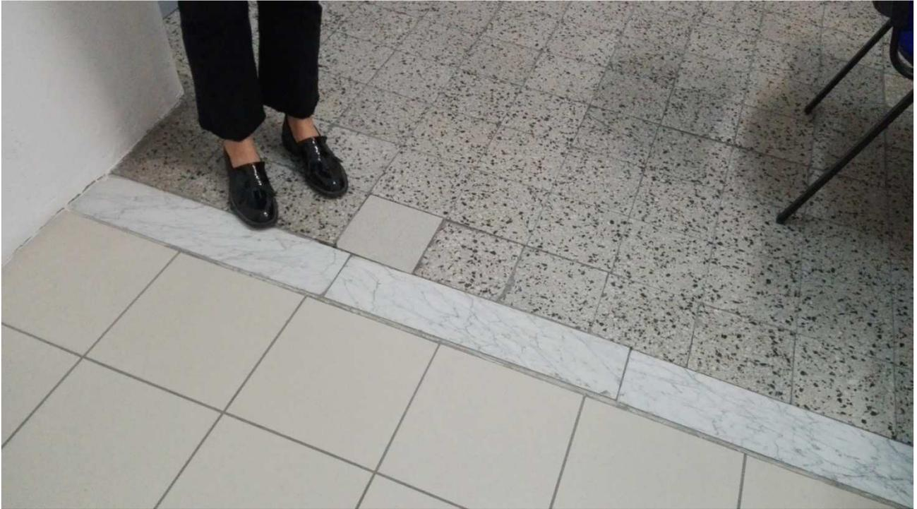
Pavimento in graniglia del piano primo con interventi di rifacimento di porzioni in gres porcellanato a seguito di demolizione di tramezzature (vedi listatura in marmo bianco) per modifica distributiva degli spazi interni effettuata in tempi relativamente recenti.
