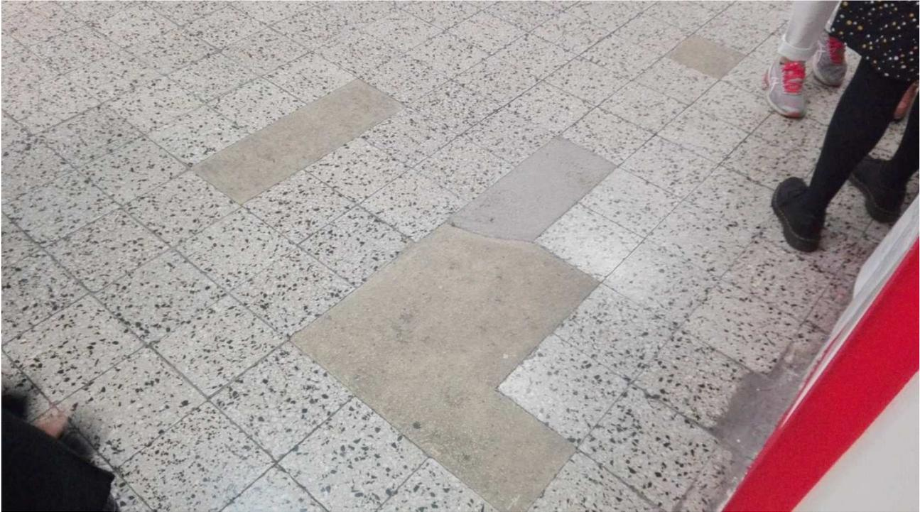
Pavimento in graniglia del piano primo con interventi di rimaneggiamento e sostituzione piastrelle con cemento
