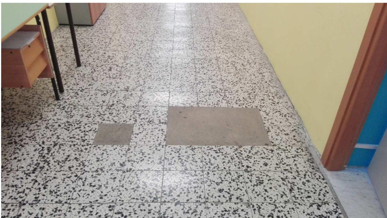
Pavimento in graniglia del piano primo con interventi di rimaneggiamento e sostituzione piastrelle con cemento
