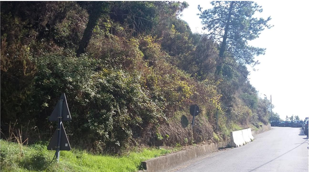
**FOTO 2 vista della zona contigua attualmente dotata di reti fessurate con rigonfiamenti di trattenuta di materiale terroso/lapideo**
