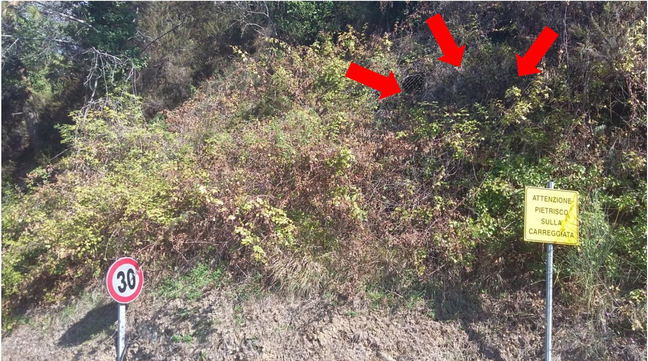
**FOTO 3 massa detritica distaccatasi dalla scarpata stradale trattenuta dalle reti corticali esistenti**
