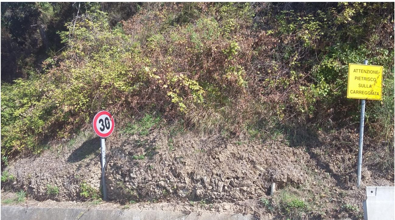
**FOTO 4 vista di dettaglio di massa detritica distaccatasi dalla scarpata stradale trattenuta dalle reti corticali esistenti**
