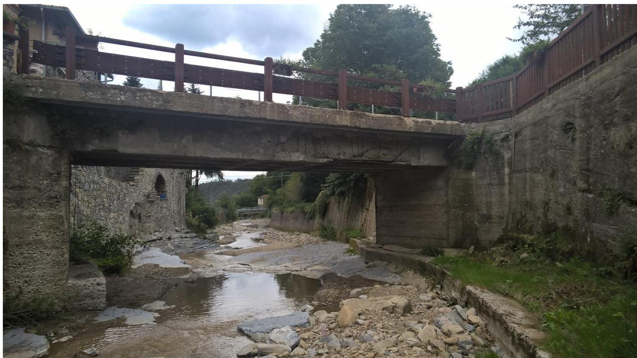
Il progetto prevede la demolizione del manufatto attuale e la successiva ricostruzione di una nuova soletta carrabile progettata in struttura mista acciaio e calcestruzzo armato. La soluzione proposta consente di limitare l'altezza dell'impalcato in modo tale da ottenere un'altezza complessiva dell'impalcato stradale pari a 70 cm.
